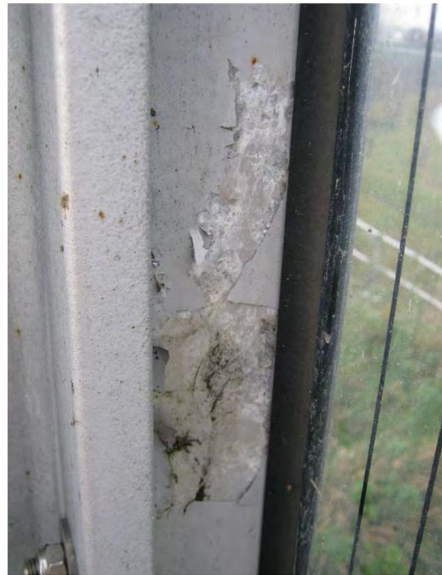
An diesen pulverbeschichteten Aluminiumprofilen kam es nach ca. zwei Jahren zu einem teilweise großflächigen Abplatzen der Beschichtung. Quelle: DFO
