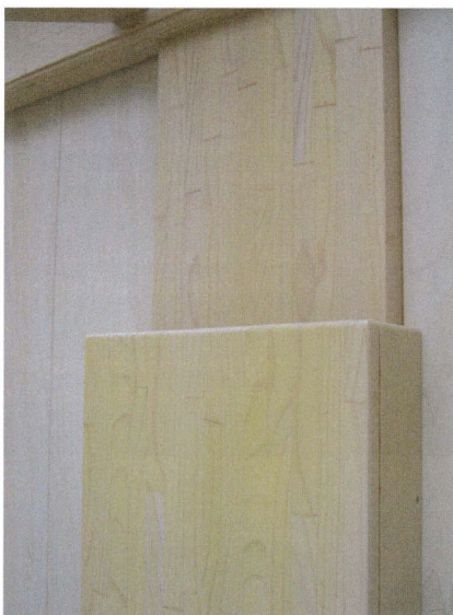
Bild 1 > Circa ein Jahr nach der Fertigstellung eines Wintergartens kam es zu unregelmäßigen Vergilbungen an den Holzträgern, die sich mit der Zeit noch verstärkten.
