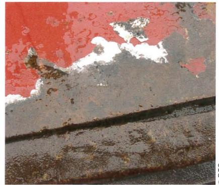
**Bild 3** > Mangelhafte Lackierung, verursacht durch nicht entfernte Fette und Öle beim Strahlprozess.
