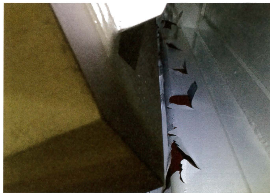
Bild 1 > Strahlmittelreste verhinderten bei diesen Bauteiloberflächen den Verbund zwischen Grundierung und Werkstückoberflächen. Die Beschichtung löste sich großflächig von der Bauteiloberfläche.
