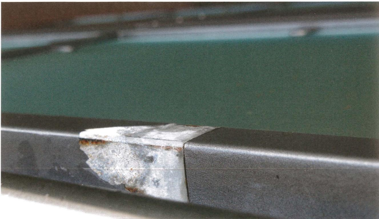
Nicht entfernte Weißrostschicht führt zur Delamination der Beschichtung. Teilweise wurde die Verzinkung entfernt und die Rotrostbildung ist zu erkennen.
