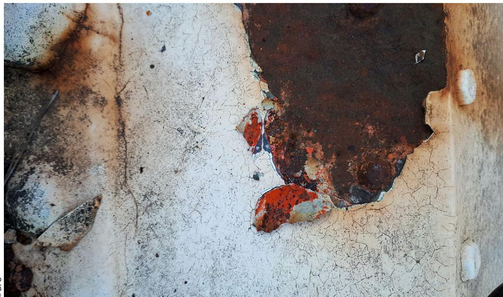
Beispiel eines Schadensbildes: Korrosionsschutzbeschichtung mit Haftfestigkeitsstörungen.
