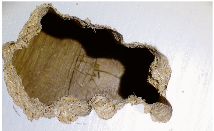
Bild 2 > Komplizierte Probennahme: Die alte Beschichtung befand sich unter einem Schrank. Um an die Lackprobe zu gelangen, wurde ein Loch in den Schrankboden geschnitten.
