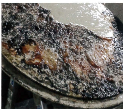
Dieser Belag auf dem Deckel eines Tanks zeigt schon ohne weitere Analysen das Vorhandensein von unerwünschten Bakterien.
